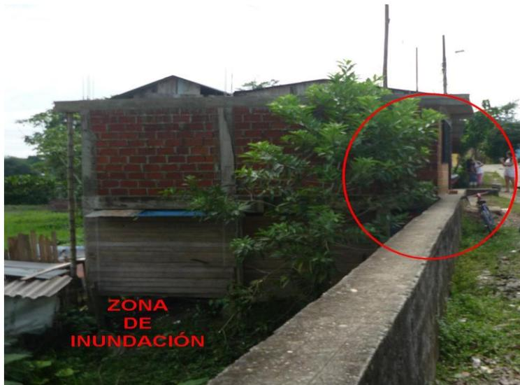
FOTO 3. Vivienda construida en zona de inundación, apoyada en muro de contención
